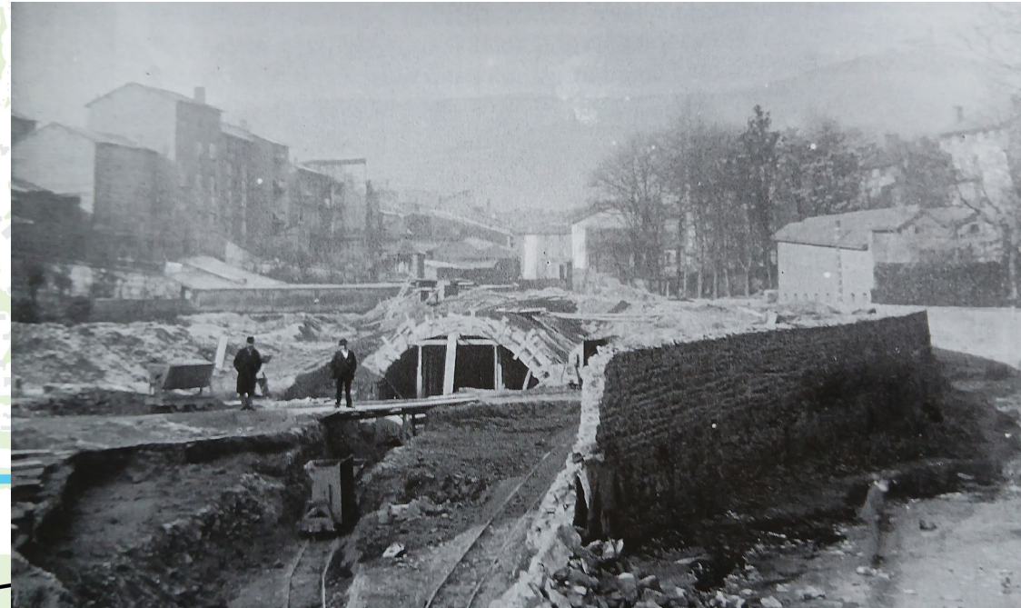
Travaux d'enfouissement de la Turdine en 1898 - boulevard Voltaire
